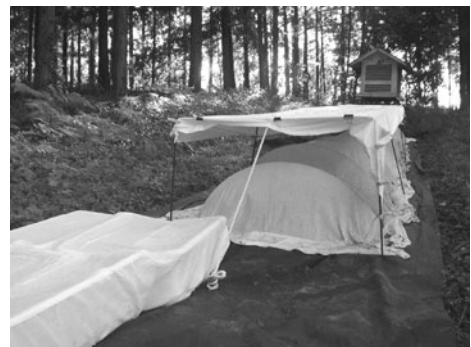
写真-1 畑地埋設状況
