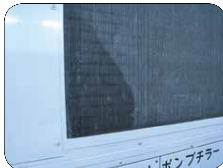
熱交換器の油のにじみ
