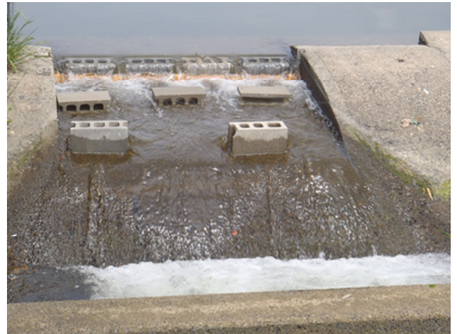
図7 改善後の鴨越堰右岸魚道
