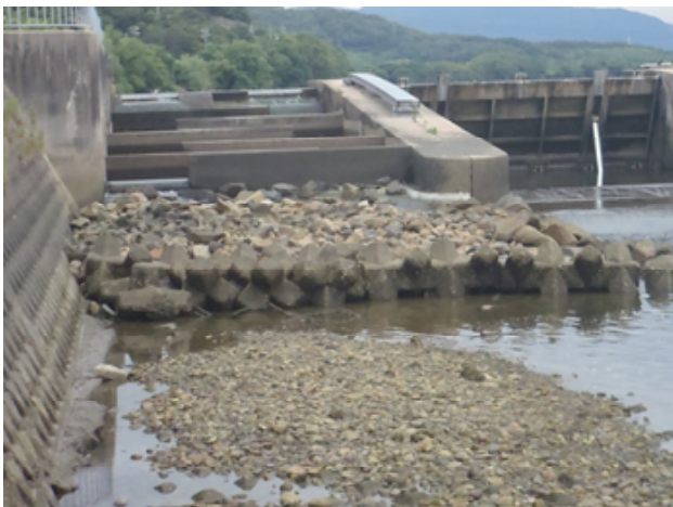
図6 干潮時の鴨越堰右岸魚道
