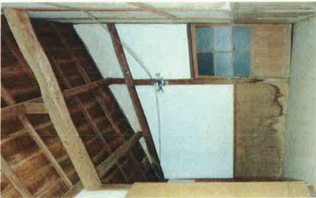
29 東校舎 北側下屋 (西より見る)
