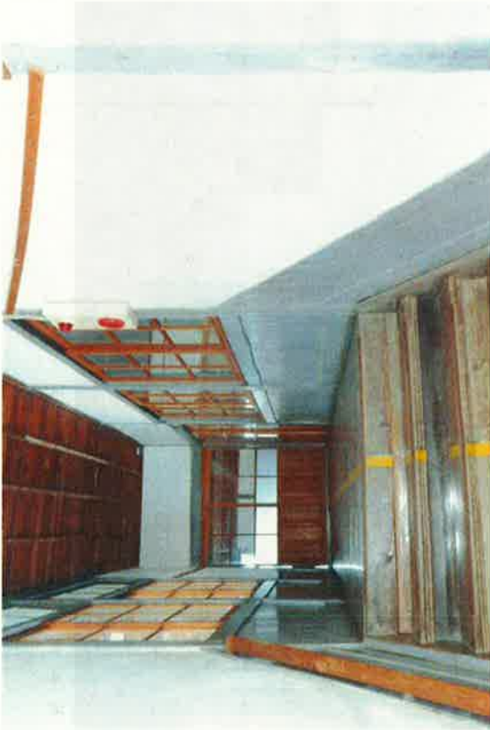
21 本館 西階段及び2階廊下
