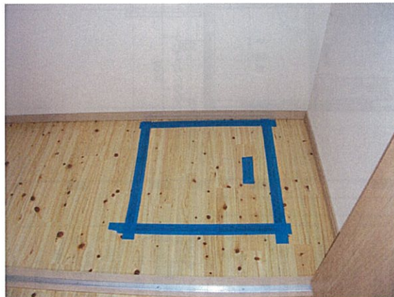
写真：04_床下点検口目張り状況
