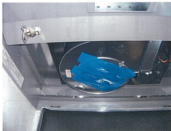
写真：04_レンジファン目張り状況
