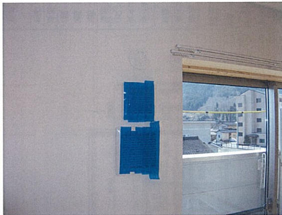
写真：02_洋室 換気レジスター目張り状況
