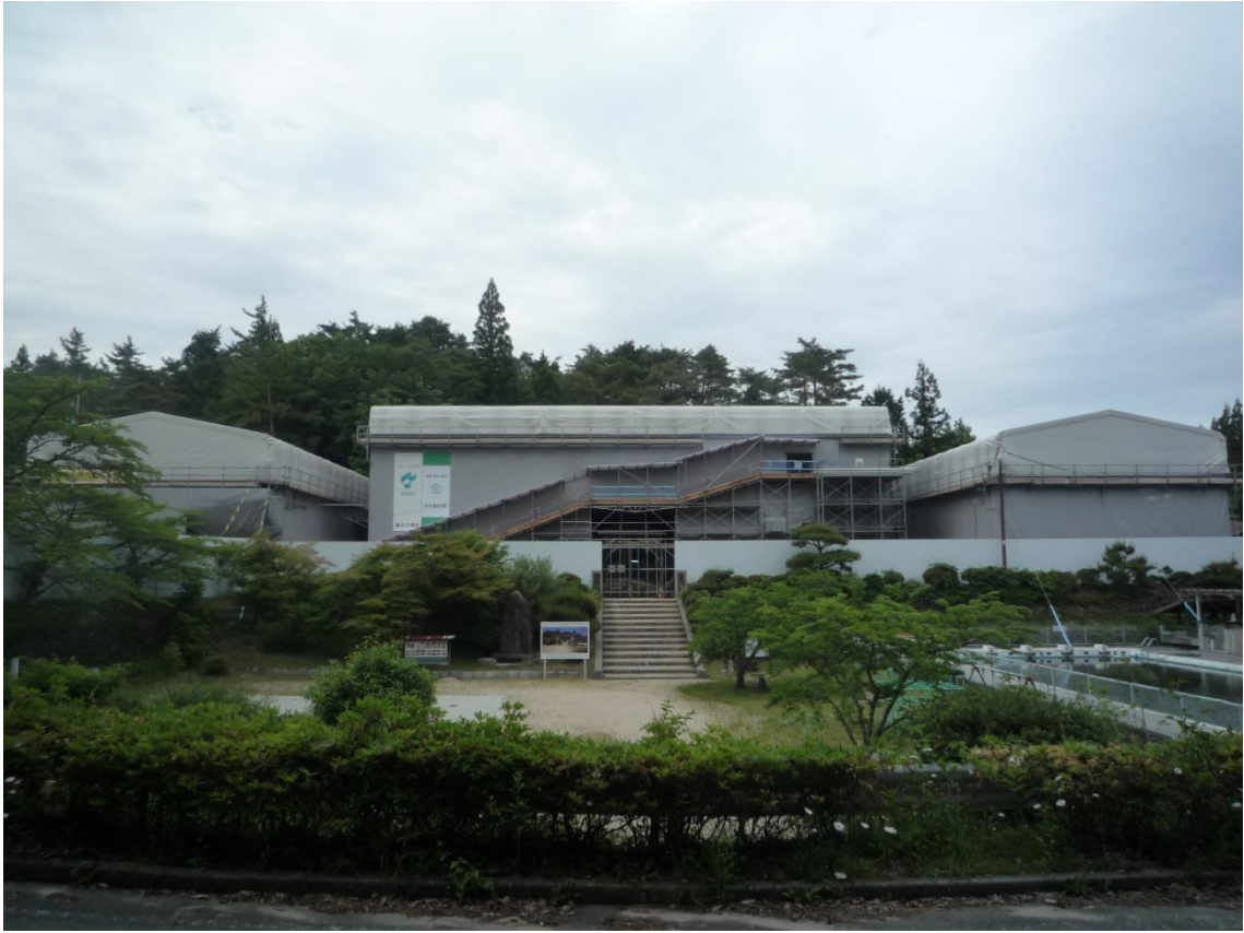
工事現場全景
