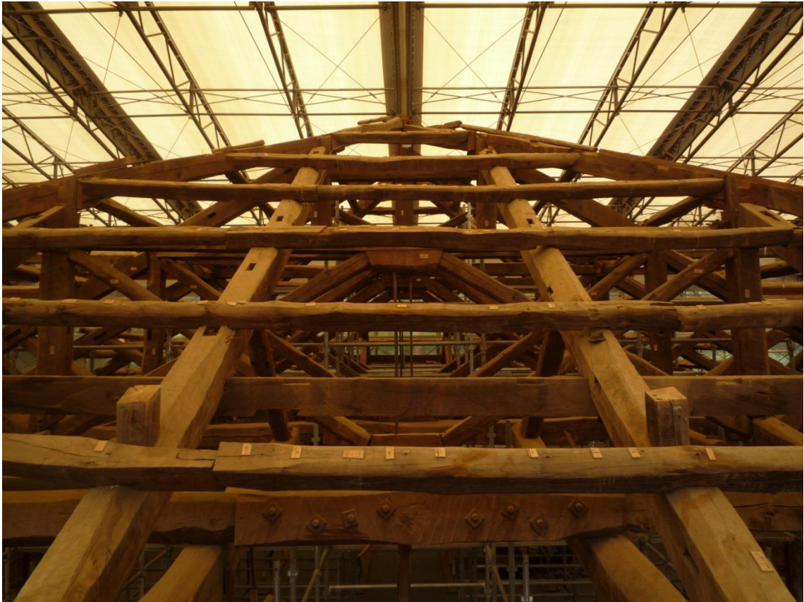
屋根トラスの様子
