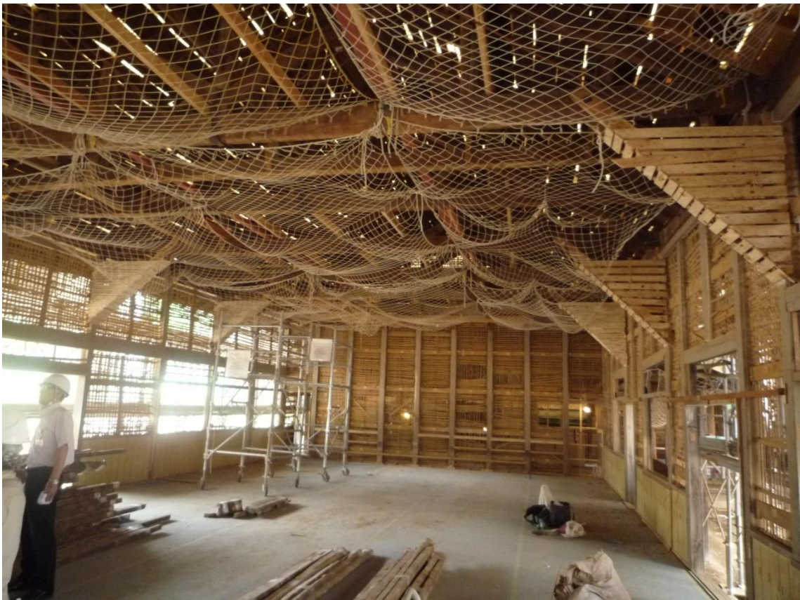
西校舎内部の様子
