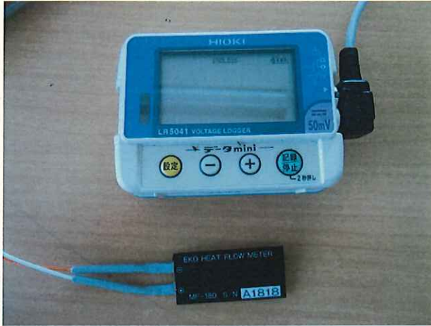
写真-54 設置器材
