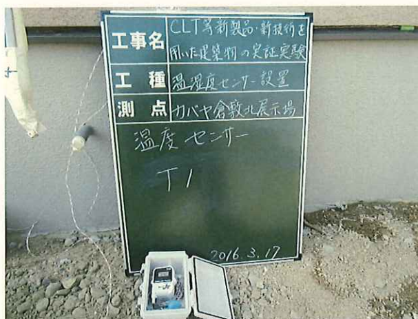
写真-47 データロガー設置状況
