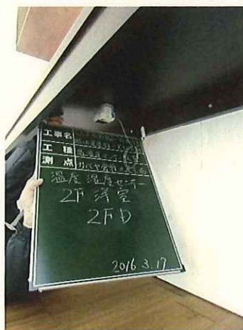
写真-25 設置状況
