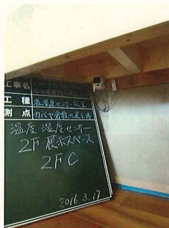
写真-23 設置状況
