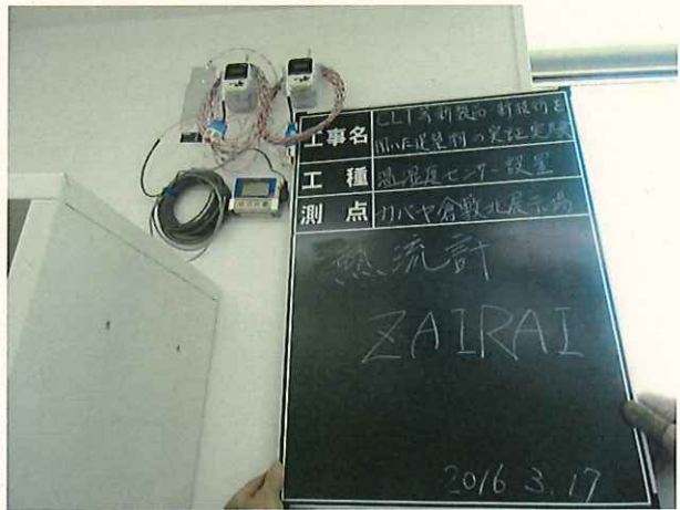
写真-57 設置状況
