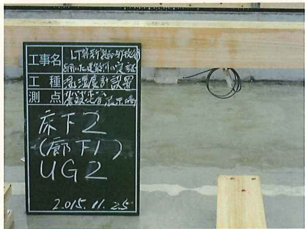
写真-29 設置状況
