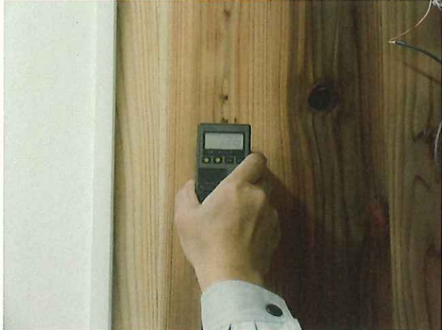
写真-59 調査状況
