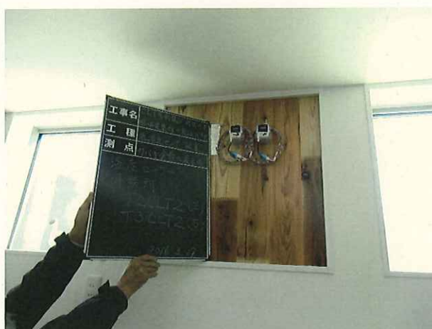
写真-45 設置状況
