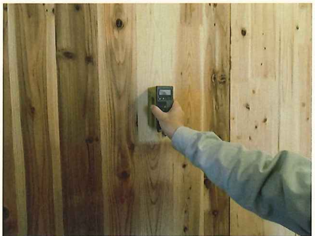
写真-65 調査状況
