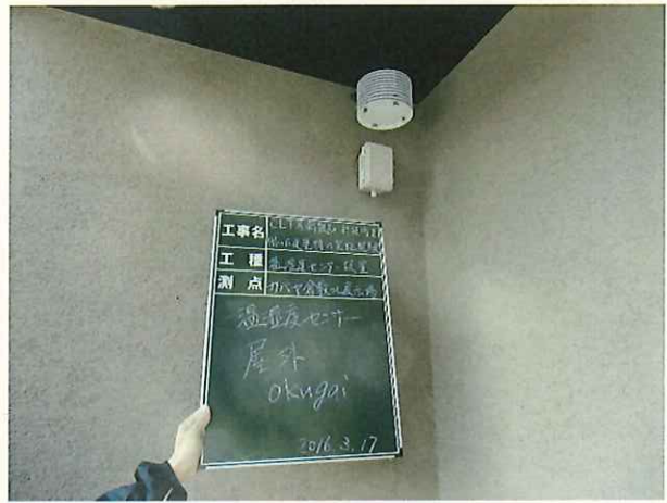
写真-9 設置状況
