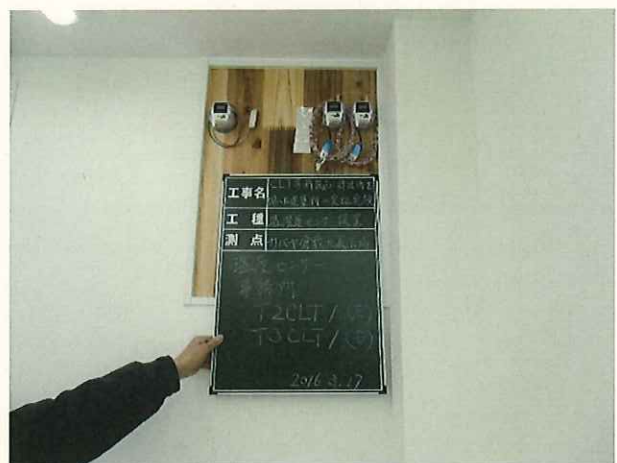
写真-39 設置状況
