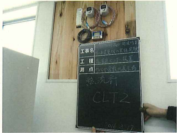
写真-55 設置状況
