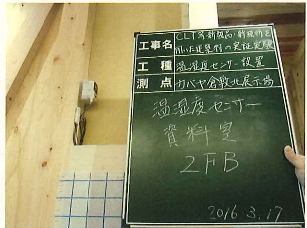
写真-21 設置状況
