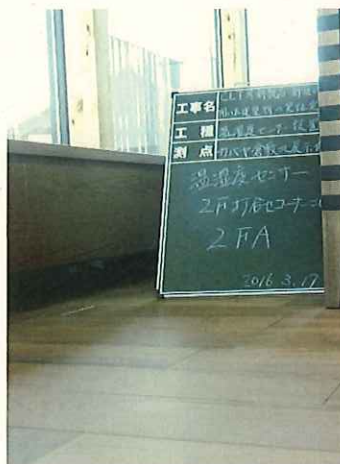
写真-19 設置状況
