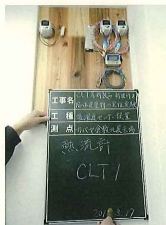
写真-53 設置状況
