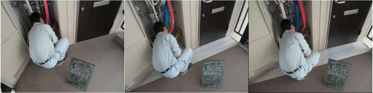
写真一八 含水率調査状況（平成27年7月7日）
