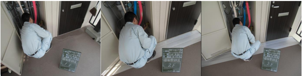
写真一七 含水率調査状況（平成27年6月24日）
