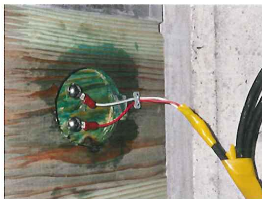
写真 2.5 基礎センサ設置状況
