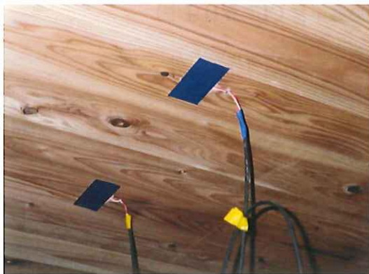
写真 2.4 天井センサ設置状況
