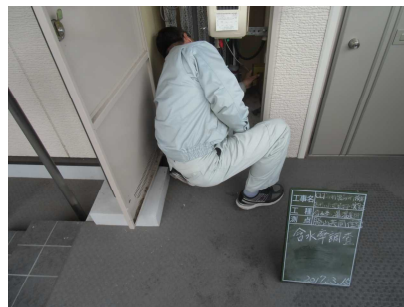
写真-19 含水率調査状況 (⑯)
