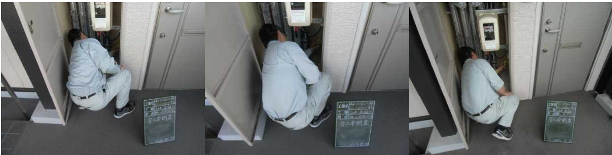
写真-4～6 含水率調査状況 (①・②・③)
