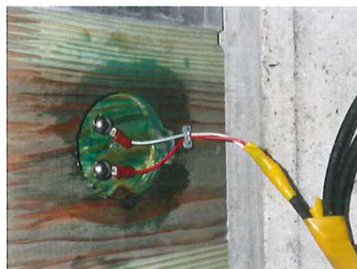
写真 2.5 基礎センサ設置状況
