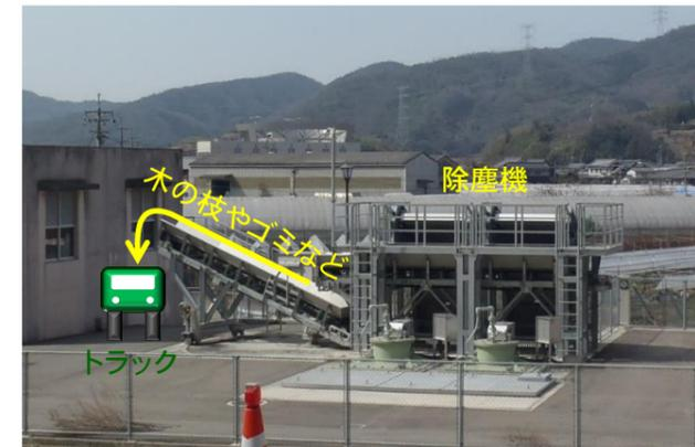
左の写真の反対方向から撮影した写真です。除塵機で除去された木の枝やゴミなどはトラックに積み込まれ処分されます。
