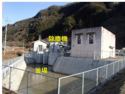
全景写真です。手前の水槽のような所が一時的に水を貯める「釜場」といいます。
