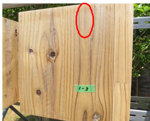
図 14 材端面から材表面への割れ進展 (別添資料 1 : 各種塗料による塗装試験体(懸架)の外観写真)
