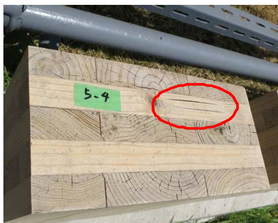
図 13 ラミナ桎目部分の材割れ
