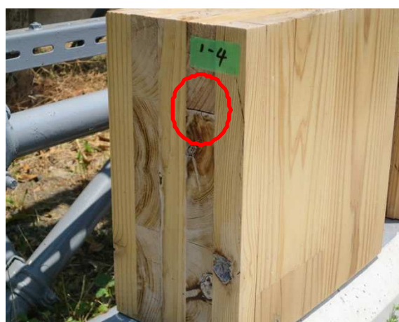
図 12 側端面にも見られる幅はぎ部の隙間
