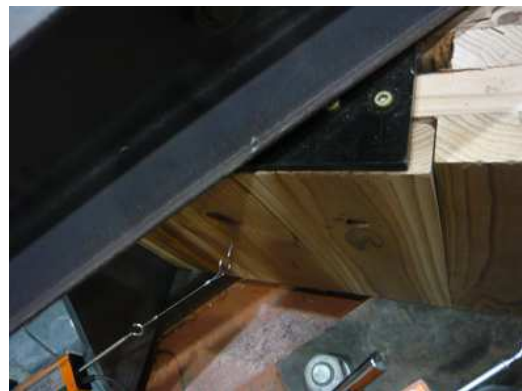
写真 3.3.2 実験 3 の破壊状況 (写真 3.3.1 の側面)
