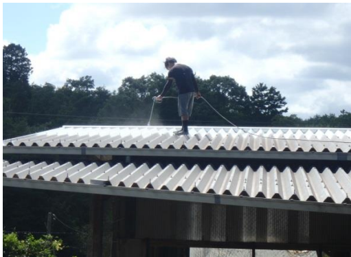
施工中の写真
