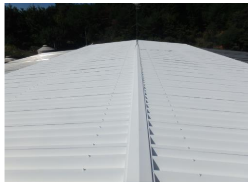
施工後の写真
