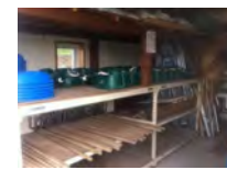
付帯施設 (農機具庫)
