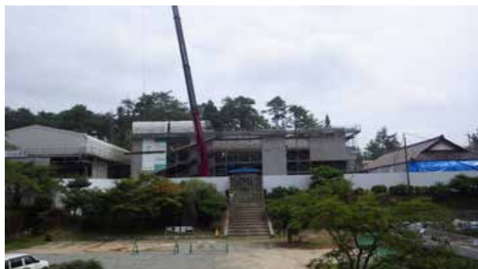
本館 素屋根解体
