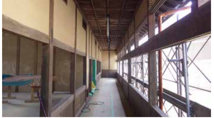
東校舎 廊下（西側）
