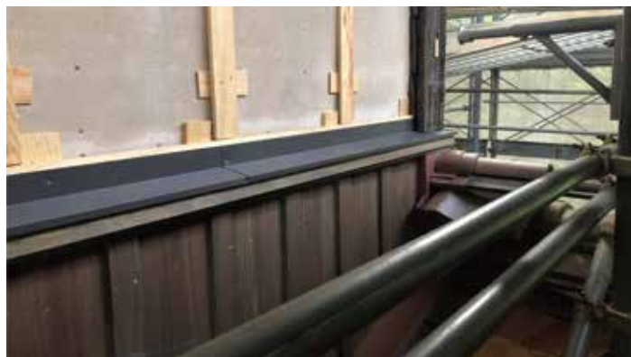
本館 2階 北東側外壁下地等
