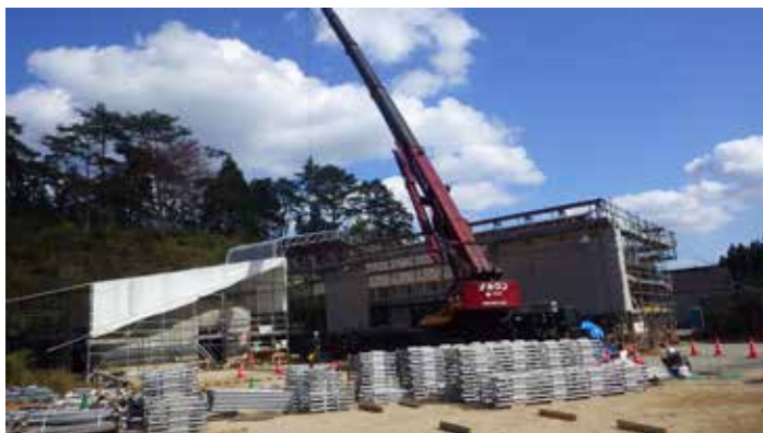
西校舎 素屋根解体
