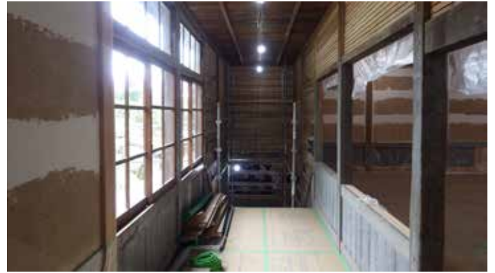
本館 2階 廊下(東側)
