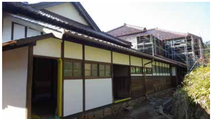
東校舎・東廊下 北側外観
