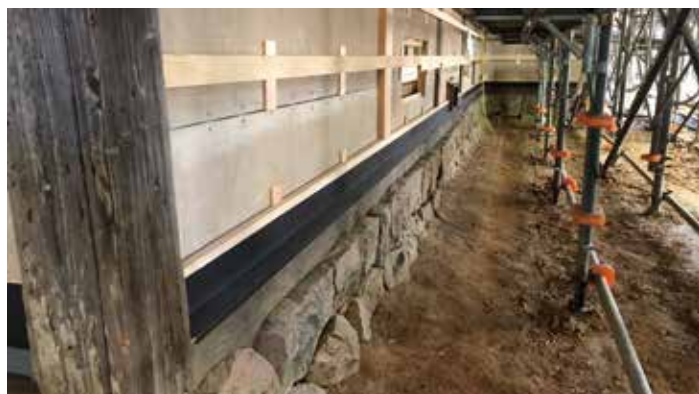
本館 1階 南西側外壁下地
