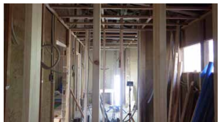
西廊下 トイレ内部
