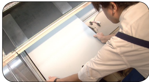
ショーケースの床板をはずします。
