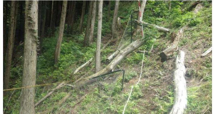
図 - 6 侵入防止柵に発生した破損（倒木落枝）
