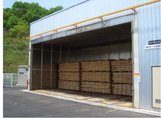
写真8 中温蒸気式乾燥装置の内部
