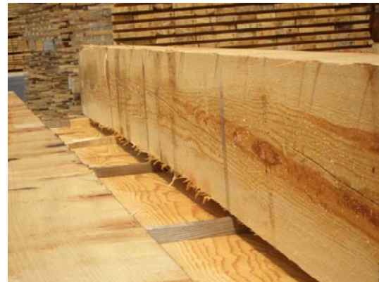
写真 15 ある程度材面割れが発生する
