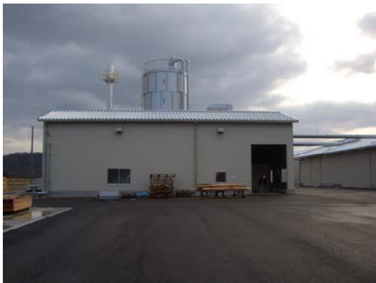
写真9 木屑焚きボイラー棟
