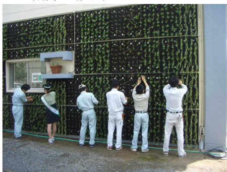
植栽中の状況
