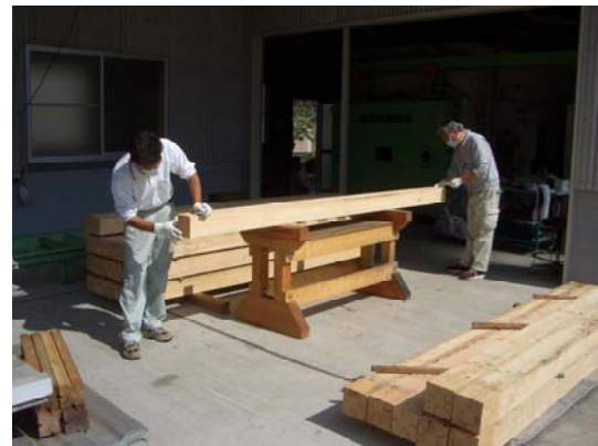
写真4 木口面のコーティング
