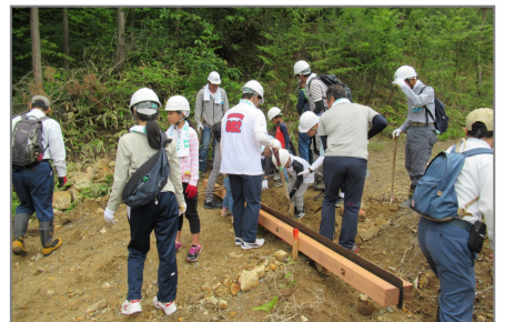
作業道の修繕
