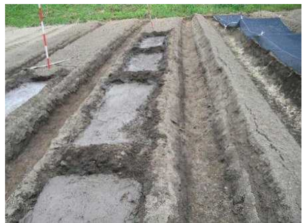
図－5 練り床①（整地及び練り土）
