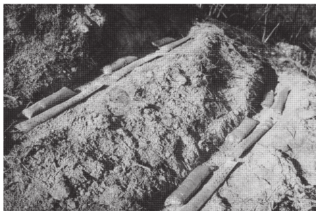
写真-8 棒状A1マットの設置
