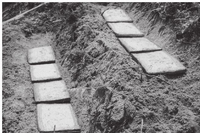
写真-11 Gマットの設置
