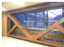
(鉄骨ブレースによる耐震補強)
