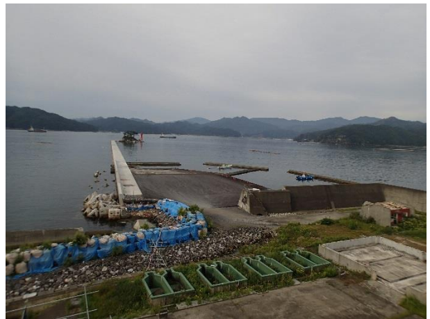
修繕途中の港湾施設
