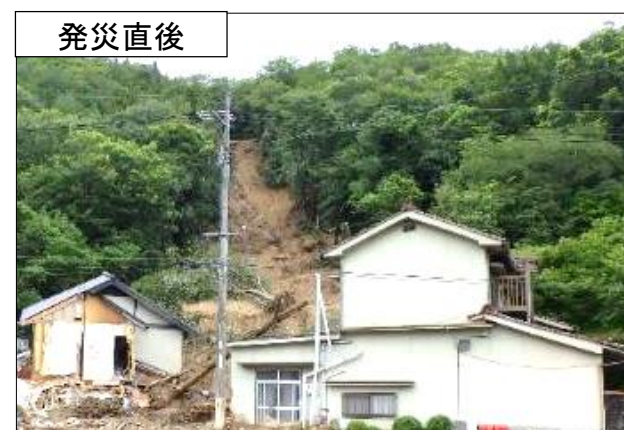
民家裏の山腹崩壊の状況 （井原市西江原町）
