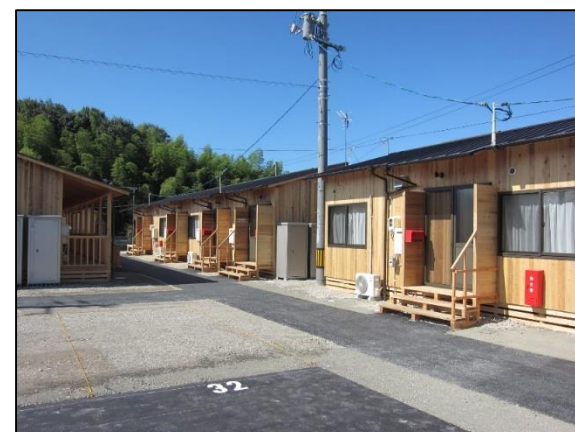
木造仮設住宅（倉敷市真備町）
