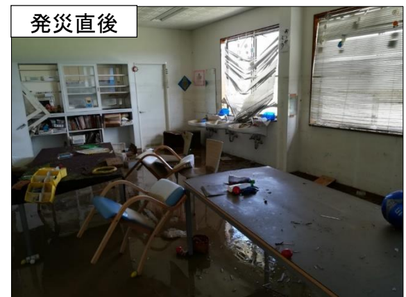
発災直後 障害者施設の被災状況
