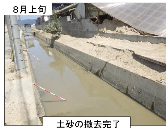
農業用水路の復旧状況（倉敷市真備町）
