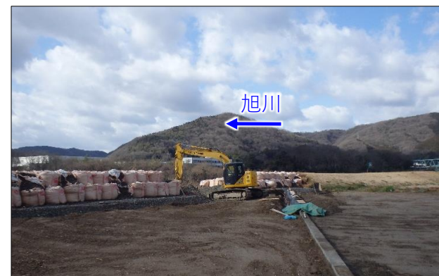
旭川（岡山市北区御津国ヶ原）の施工状況
