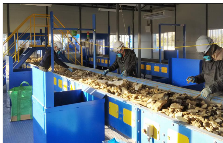
中間処理施設（二次選別処理施設 手選別ライン）
