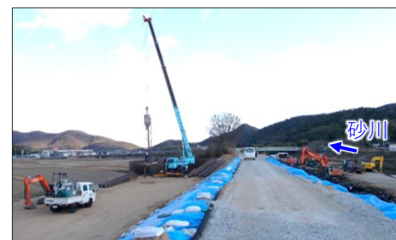
砂川（岡山市東区沼）の施工状況
