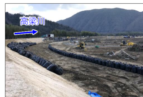
高梁川（総社市下倉）の施工状況
