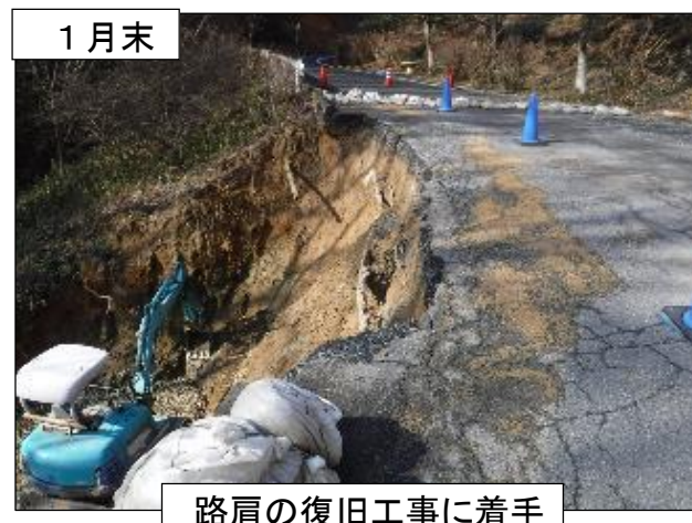
林道施設の復旧状況（岡山市北区建部町）
