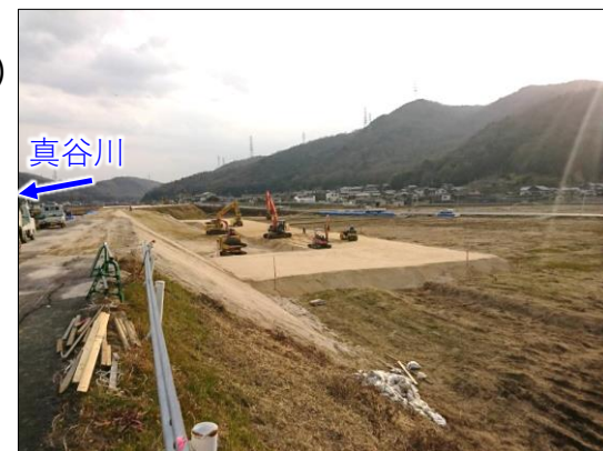
真谷川（倉敷市真備町服部）の施工状況
