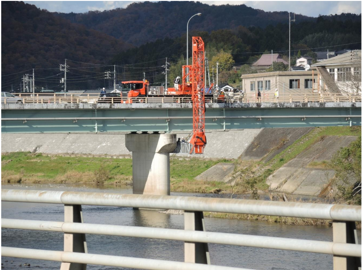
大型橋梁点検車による橋梁点検
