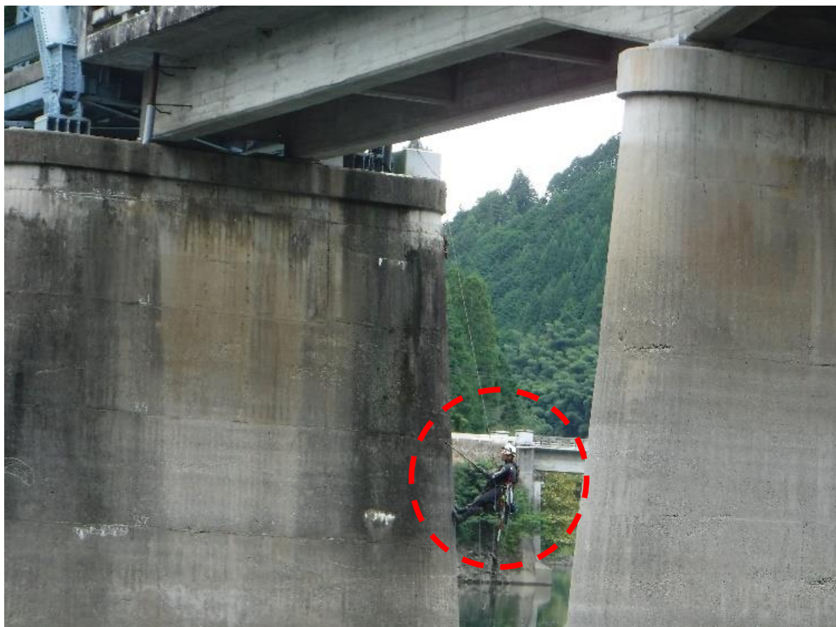
ロープアクセスによる橋梁点検
