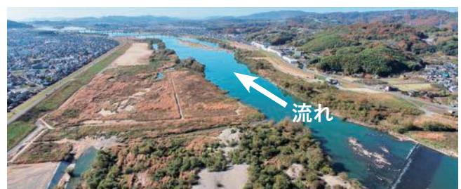
倉敷大橋より下流の様子
