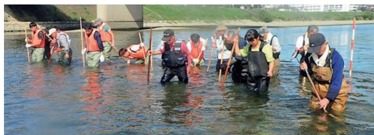
一列に並び河床を踏みならす作業
