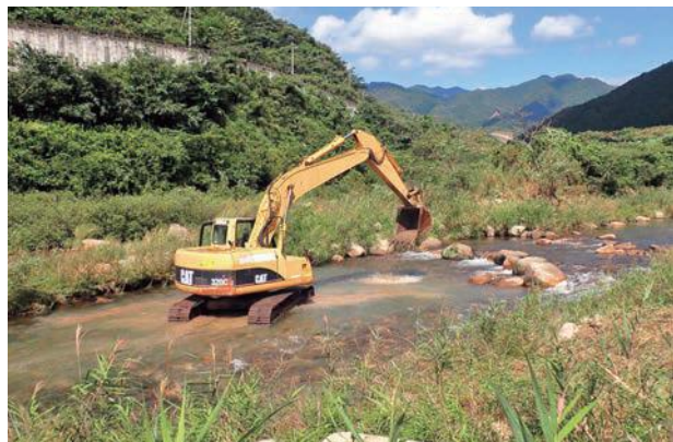
奥津湖に流入する吉井川で実施された産卵場造成（令和3年9月）
