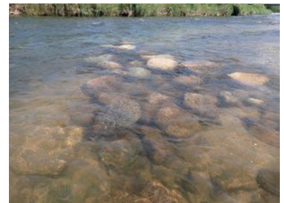
整備後の状況（礫の敷設）
