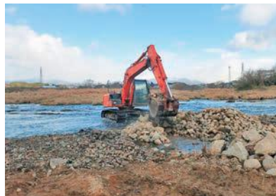
礫の敷設作業
