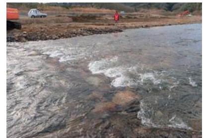
整備後の状況
