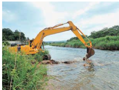
礫の敷設作業
