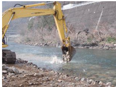
礫の敷設作業
