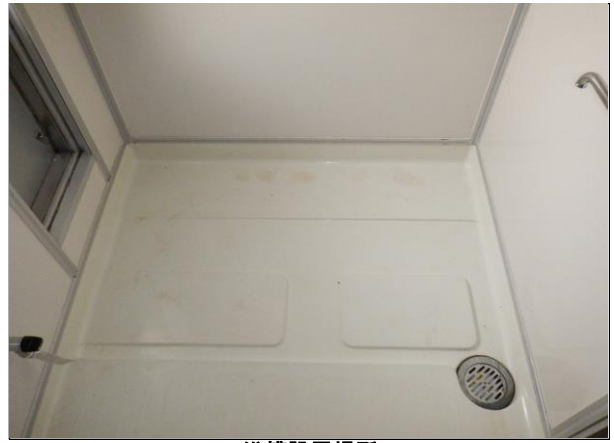
浴槽設置場所
