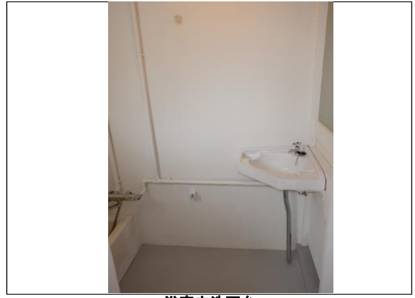
浴室内洗面台
