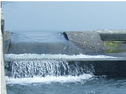
写真 18 鴨越堰右岸魚道
