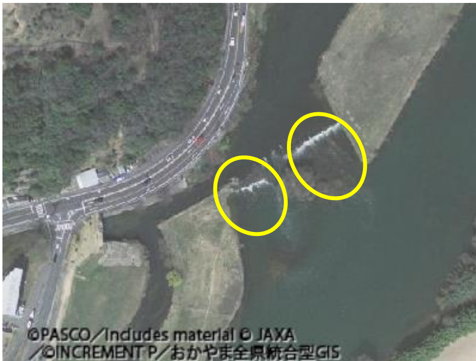
写真11 旭川江川の瀬（河口から約12km）
