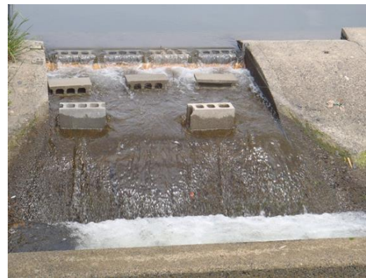
写真 19 ブロック設置後の鴨越堰右岸魚道
