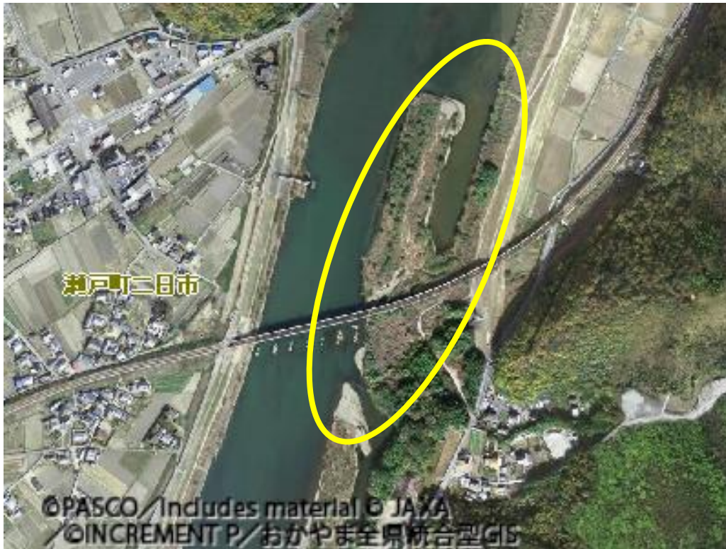
写真6 吉井川キリンビール取水塔東（河口から約21km）
