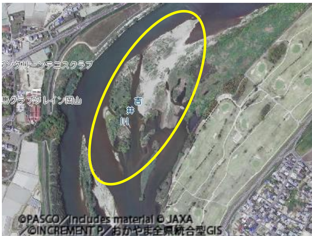
写真8 吉井川備前大橋下（河口から約13km）
