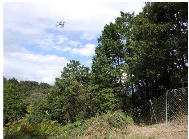
ドローンによる侵入防止柵の点検
