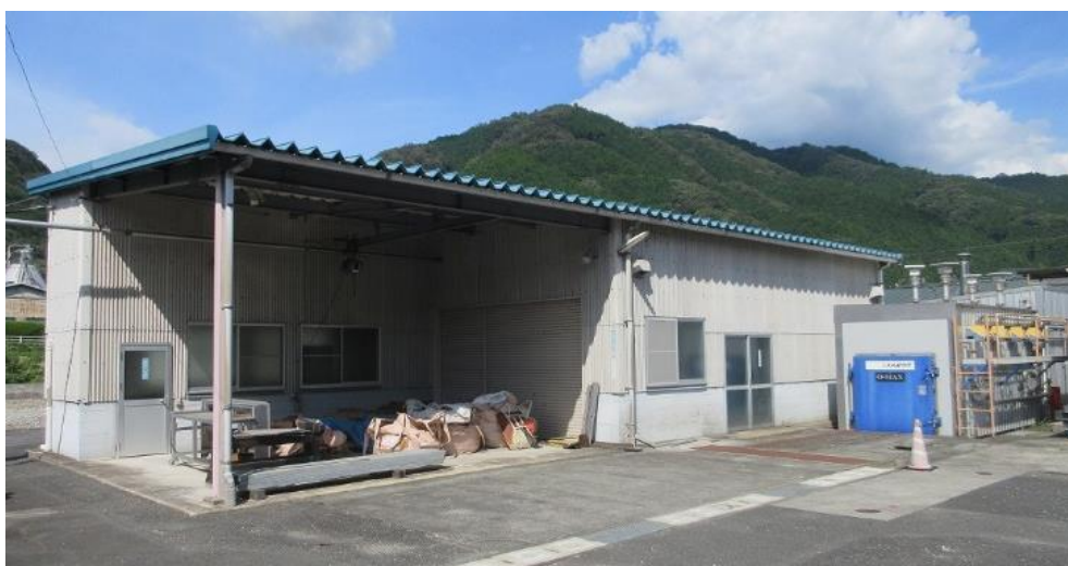
高温乾燥試験棟
