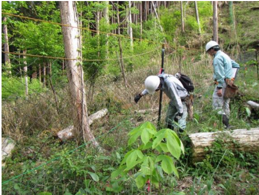
図1 踏査による防護柵の点検・補修
