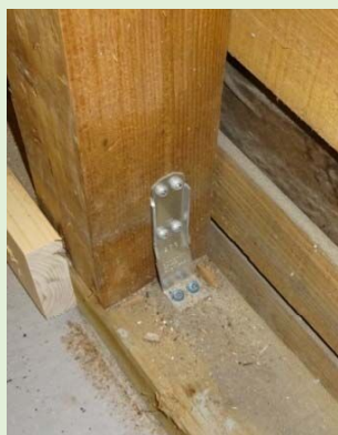
接合部金物補強
