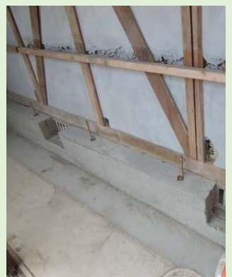
基礎補強(増打ち)
