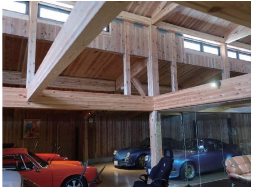
将来二階部分を増築できるように設計されている
