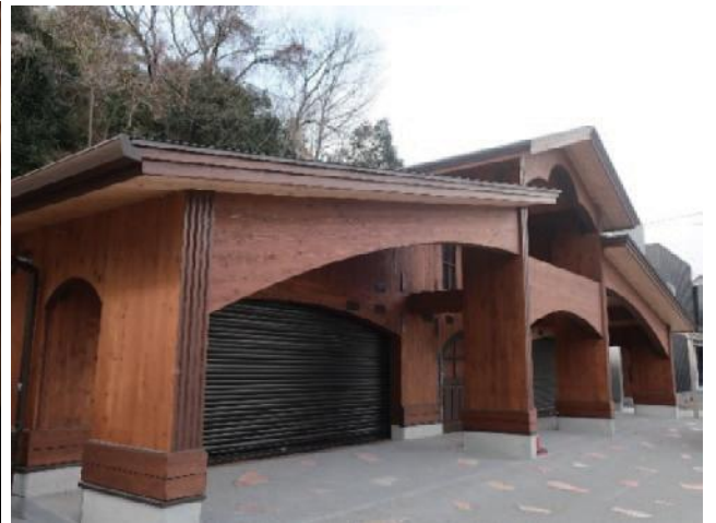
所在地：岡山市、構造：CLTパネル工法 用途：店舗(ショールーム) 階数：1、延べ床面積：199㎡
