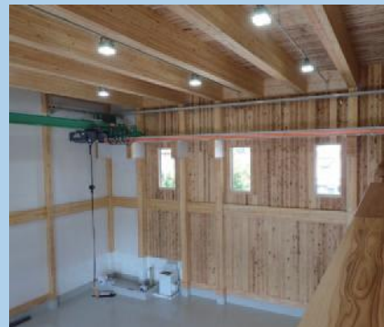
CLTパネル工法の倉庫
