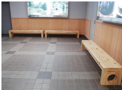
内装（腰壁）木質化、木製ベンチ
