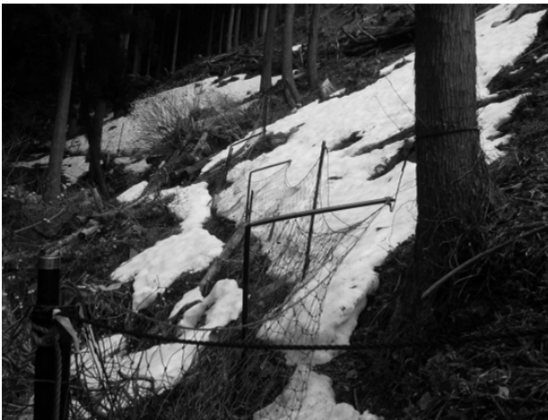
図-4 降雪による支柱の折損
