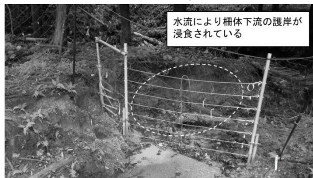
図-21 耐水害性機能調査用ロープ柵(調査終了時)
