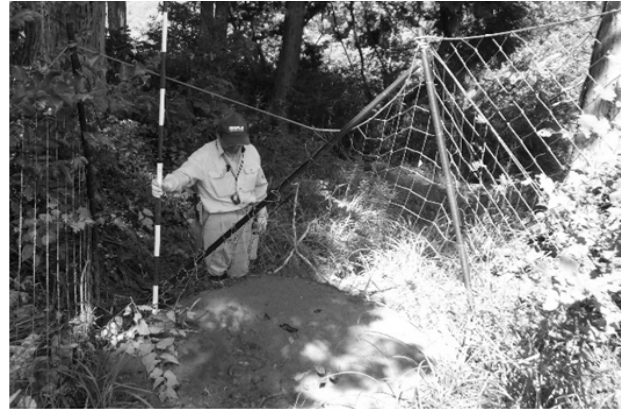
図-18 土砂崩壊・土砂移動
