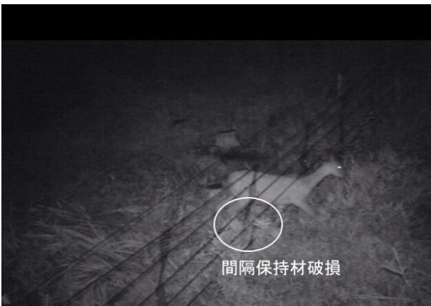
図-15 間隔保持材破損（試行柵3）
