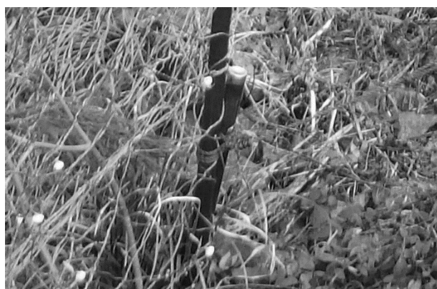
図-5 支柱欠損の補修（添え木）
