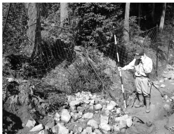
図-3 土砂の流出による柵体の崩壊
