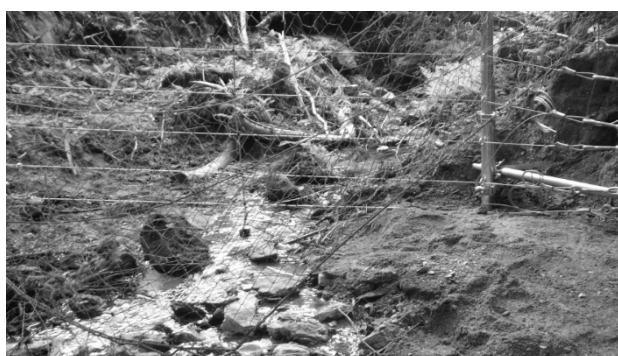
図-20 ロープ柵設置時の河床部
