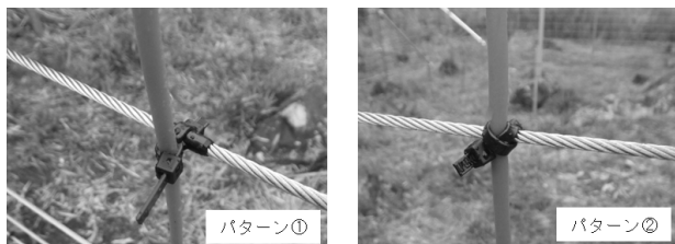
パターン①：1本をワイヤーに、1本を間隔保持材に通し結合 パターン②：2本の結束バンドをたすき掛け状に固定。
