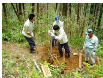
遊歩道の整備
