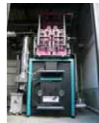
チップボイラー
