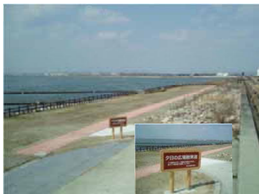
児島湾締切堤防「夕日の広場」
