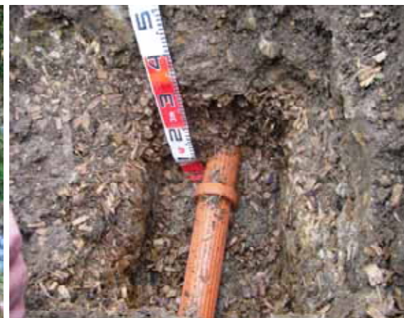
被覆材の劣化状況調査
