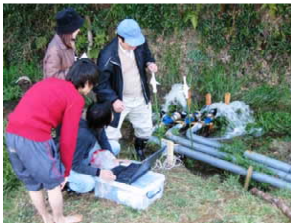
暗渠排水量調査
