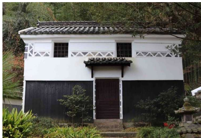
長鋪家住宅内蔵外観
