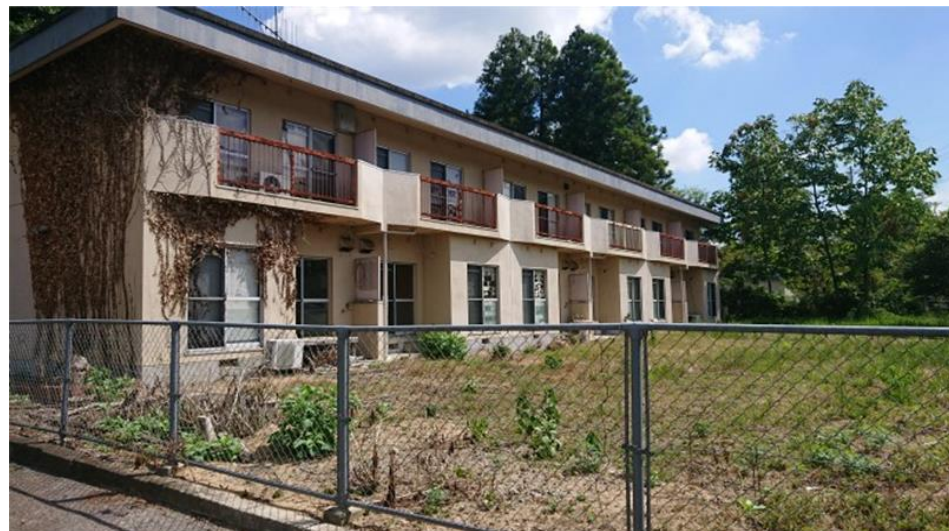
建物(2) 共同住宅
