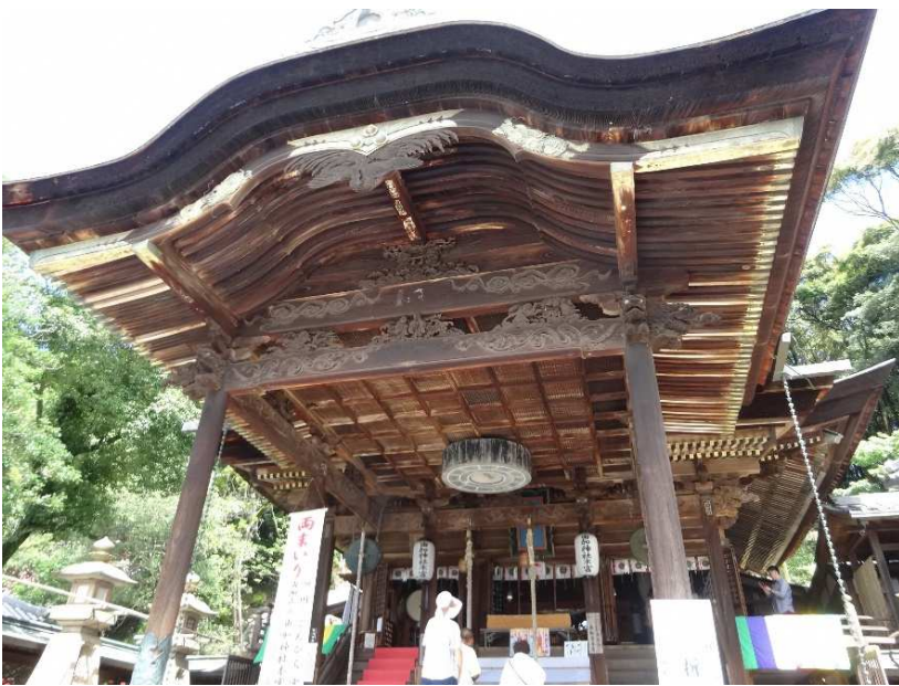
② 拝殿及び幣殿 向唐破風造向拝 見上げ
