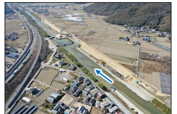
砂川（岡山市東区福治）の復旧状況
