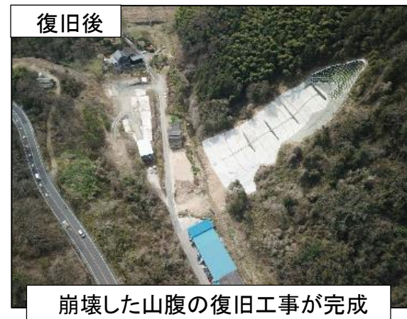
山腹崩壊の復旧状況(矢掛町横谷)
