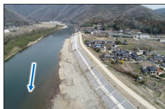
高梁川（総社市日羽）の復旧状況
