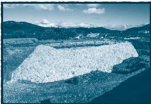
ひゃっかんがわいち であて せわ てい 【百間川一の荒手及び背割堤】(岡山市)
