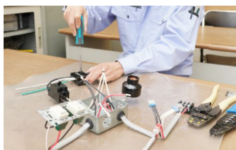
第二種電気工事士実技演習
