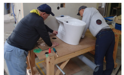
衛生器具設置
